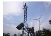
无线通信基站
