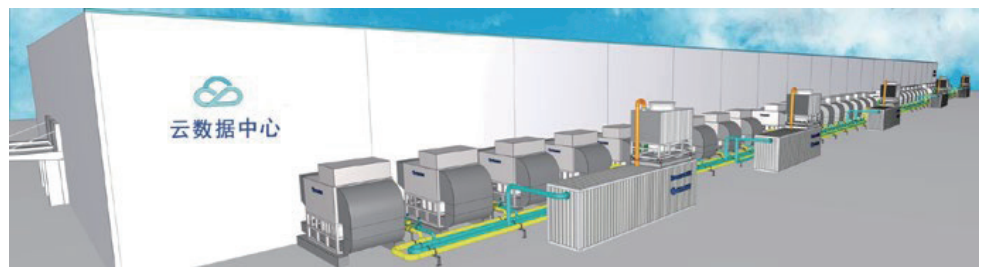
AHU系统+磁悬浮补冷模块
