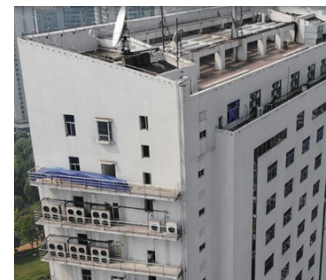
某机房室内机变频化替换+室外风改水
