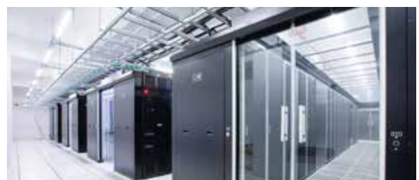
大型公司核心数据机房
